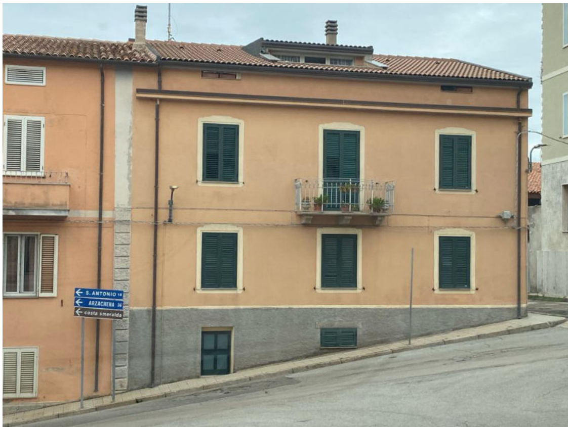
Foto n°1 vista prospetto da Via Brigata Sassari lato sud
