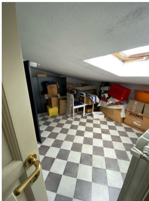
Foto n°10 particolare vano ubicato adiacente all'ingresso della soffitta
