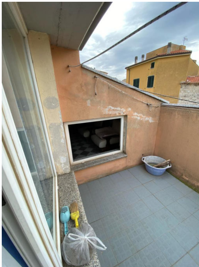
Foto n°16 particolare terrazza calpestabile del piano soffitta
