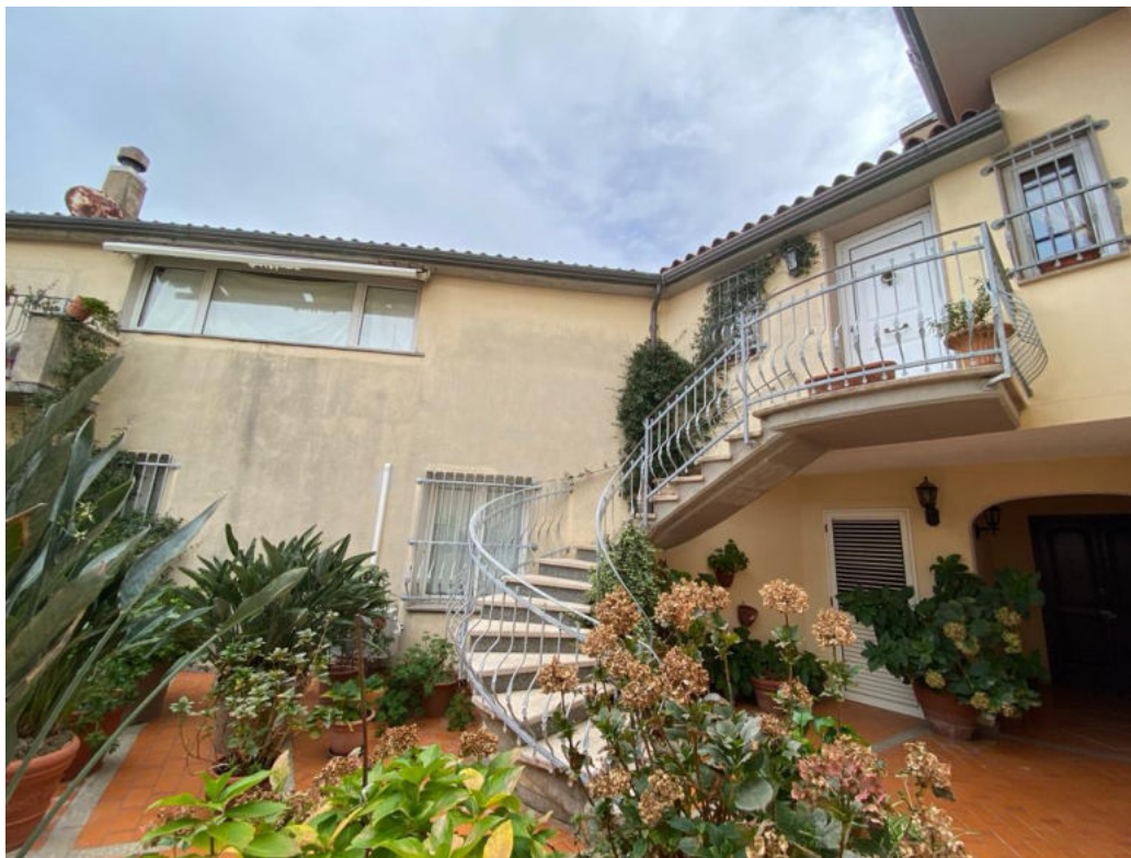
Foto n°7 vista interna cortile di ingresso comune
