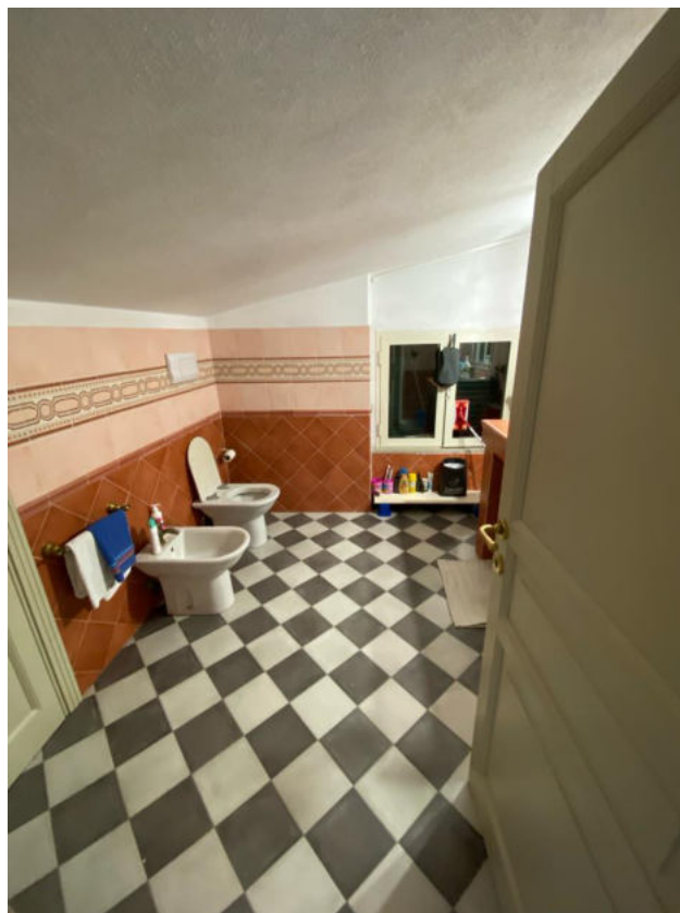
Foto n°12 bagno del piano soffitta
