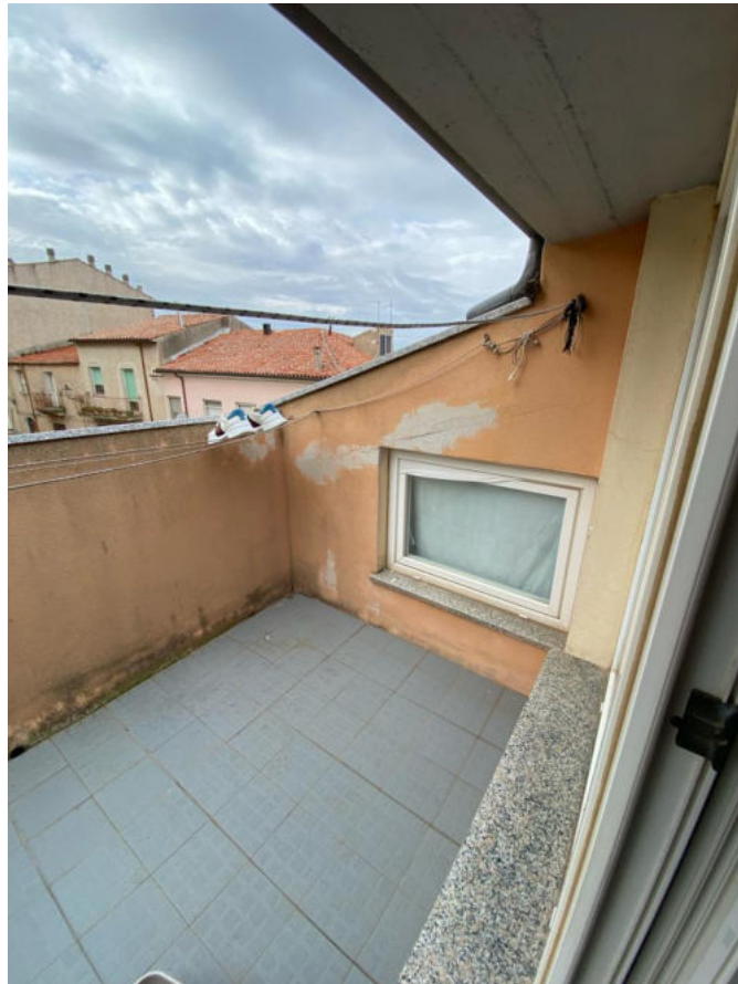
Foto n°17 particolare terrazza calpestabile del piano soffitta
