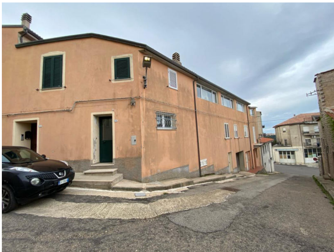
Foto n°2 prospetto Via Corsica lato nord-est
